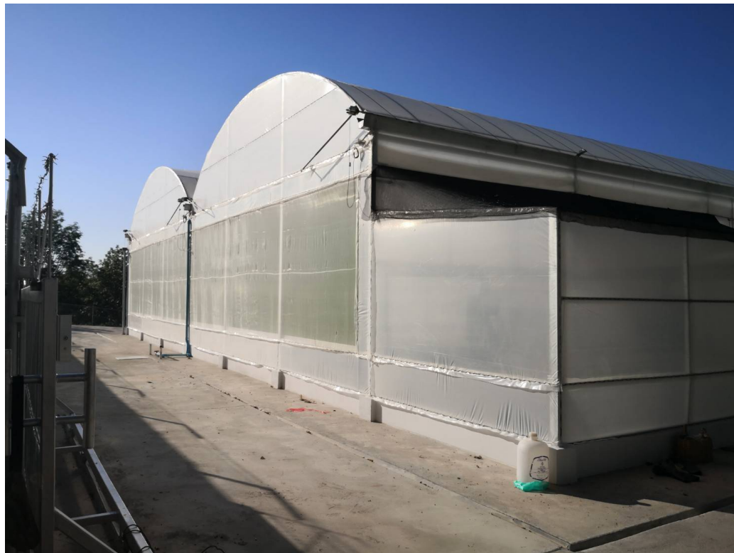
ภาพที่ 9.3.4 โรงเรือนปลูกพืชในระบบ EVAP พร้อมชุดควบคุมสภาพแวดล้อม ขนาด 9.6 x 40 เมตร ณ ฟาร์มมหาวิทยาลัยแม่โจ้ ภายใต้การกำกับดูแลของ ผศ.ดร.ปรีดา นาเทเวศน์
